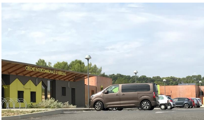
Crèche intercommunale « Le Berceau »
