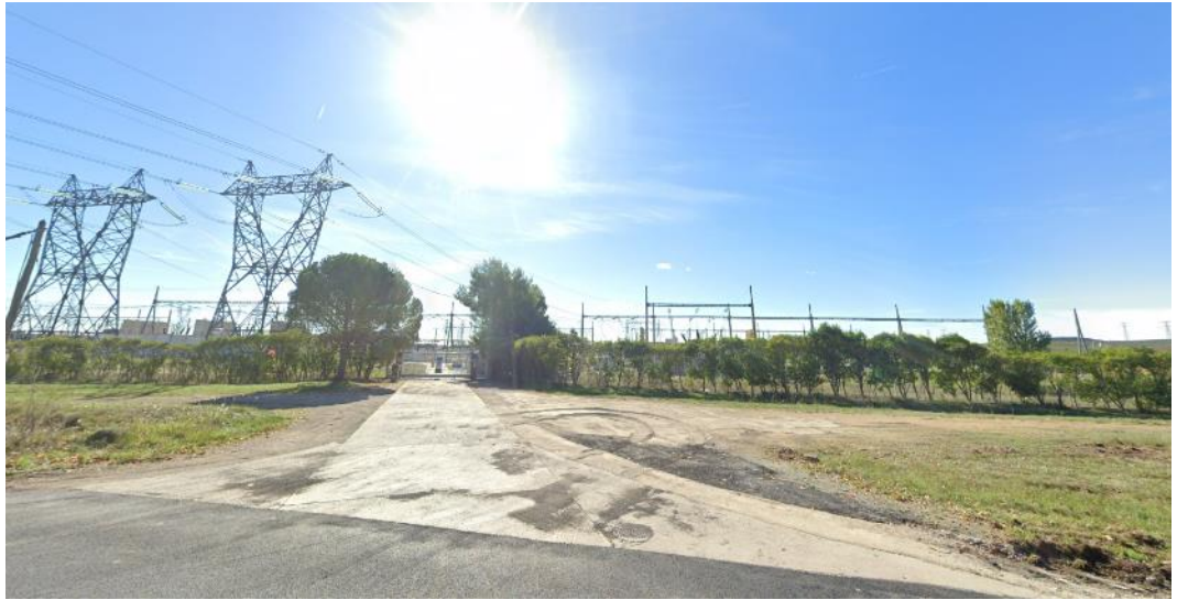
Poste électrique de Tamareau. Source : Google Street View, 2021.
