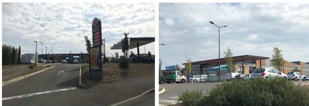
Supermarché (Source : Verdi, 2022)
