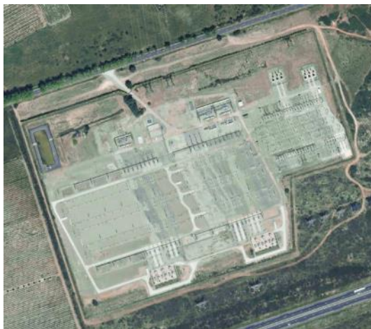
Poste électrique de Tamareau. Source : IGN, FEDER, Région Occitanie, 2018
