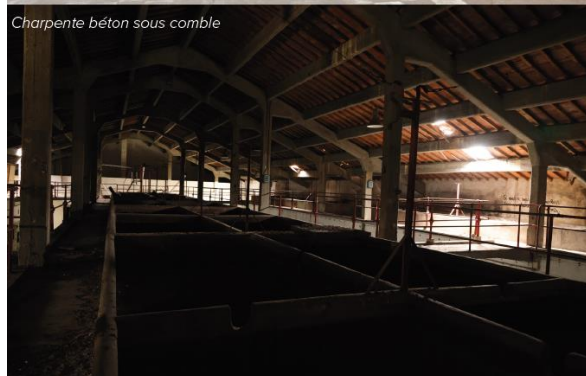
Charpente béton sous comble
